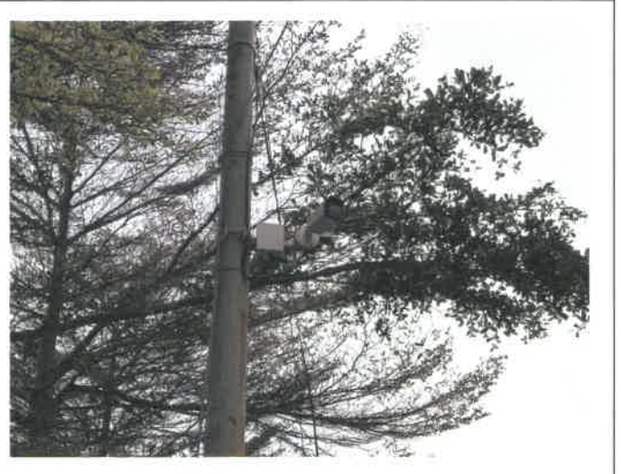
地點 1 位於遺址外西南側 1 號攝影機狀況良好。
