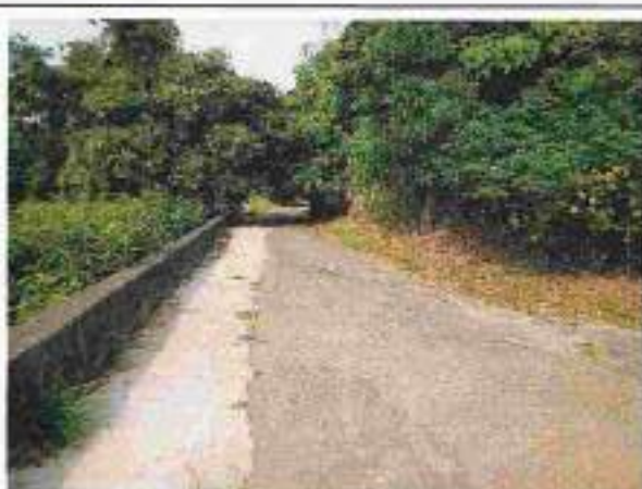
地點4 位於關林段1082地號產業道路維持現狀。
