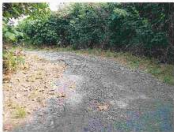
地點12 遺址東南側開林段1049-1地號產業道路維持現況。
