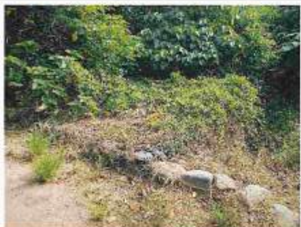
地點14 位於興林段1049-3地號西側設有箱型石籠減緩沖刷，現況維護良好。
